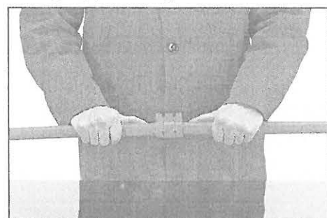
introducerea capetelor de țeavă în electromufă
